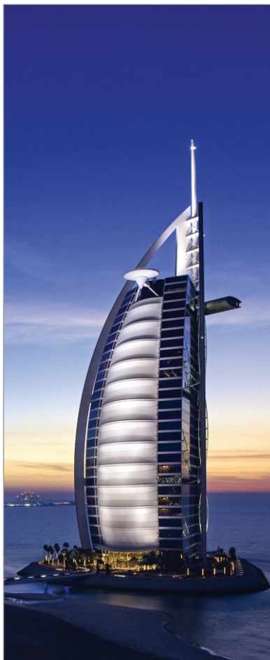
Двусторонний скотч 3M VHB активно использовался при строительстве знаменитого небоскреба Бурдж-эль-Араб
