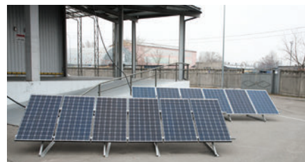
Фотоэлектрический массив панелей Panasonic 240W и LDK 255W
